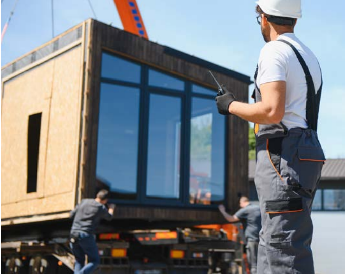
Fertighaus in Containerbauweise
