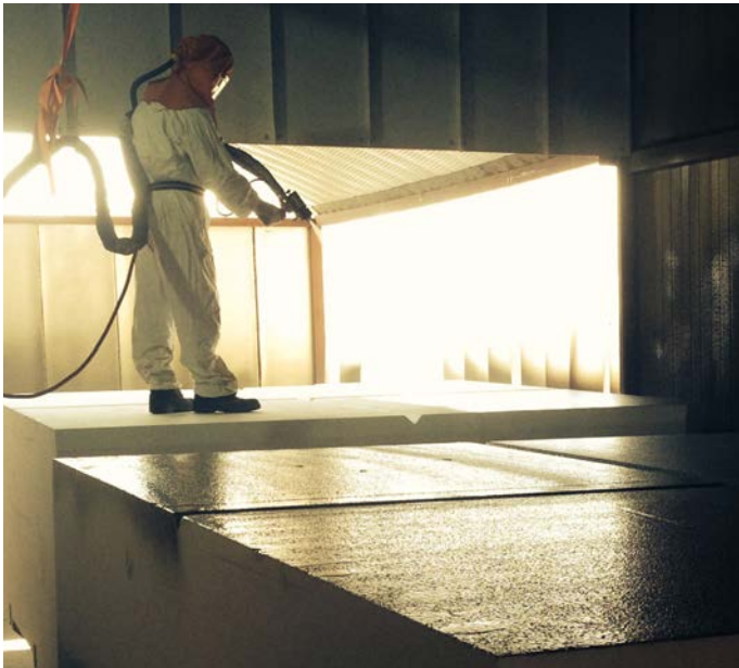
Beschichtung von EPS Blöcken
